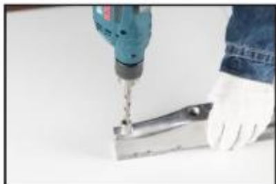
1. Висвердліть пошкоджену різьбу свердлом відповідного розміру.
