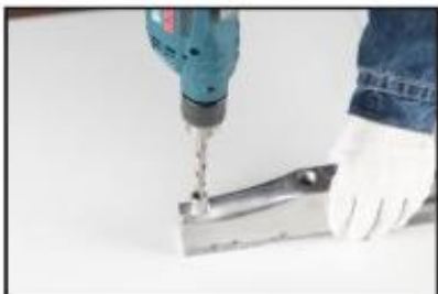
1. Przewierć uszkodzony gwint wiertłem o odpowiednim rozmiarze.
