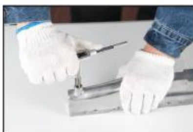
2. Κτυπήστε ελαφρά την τρυπημένη οπή χρησιμοποιώντας μια σπείρα.
