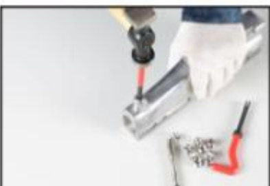
5. Используя инструмент для отламывания наконечника, отломите крепление адаптера.
